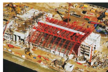
A fábrica Thermoselect, unidade de tratamento de lixo doméstico em construção na Alemanha, utilizará o oxigênio para queimar os detritos e produzir energia utilizando o gás
